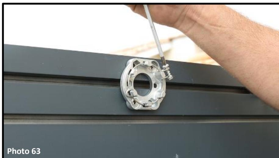
La première lame à installer est la lame moteur. Dévissez le collier de blocage du moteur (photo 63).
