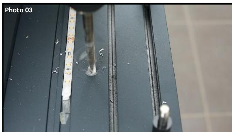
Percez la poutre murale de part en part avec un diamètre légèrement plus gros que le diamètre de la tige filetée (photo 03).
