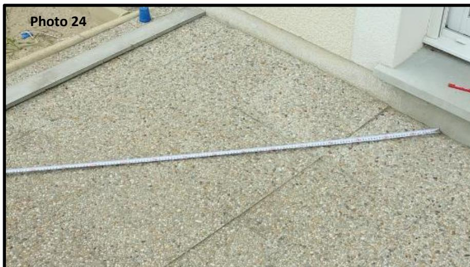
A l'aide d'un mètre ruban métallique, rejoignez les 2 traits tracés, celui parallèle à la façade à 1,20 mètre et celui perpendiculaire à 1,60 mètre en vous assurant que la règle soit restée bien droite et d'aplomb à votre mur (photo 24).
