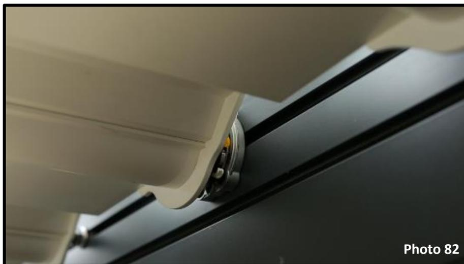
Enfoncez le 2<sup>ème</sup> bouton. Faites fonctionner les lames en appuyant sur les flèches droite ou gauche. Les réglages sont faits ! (photo 82).
