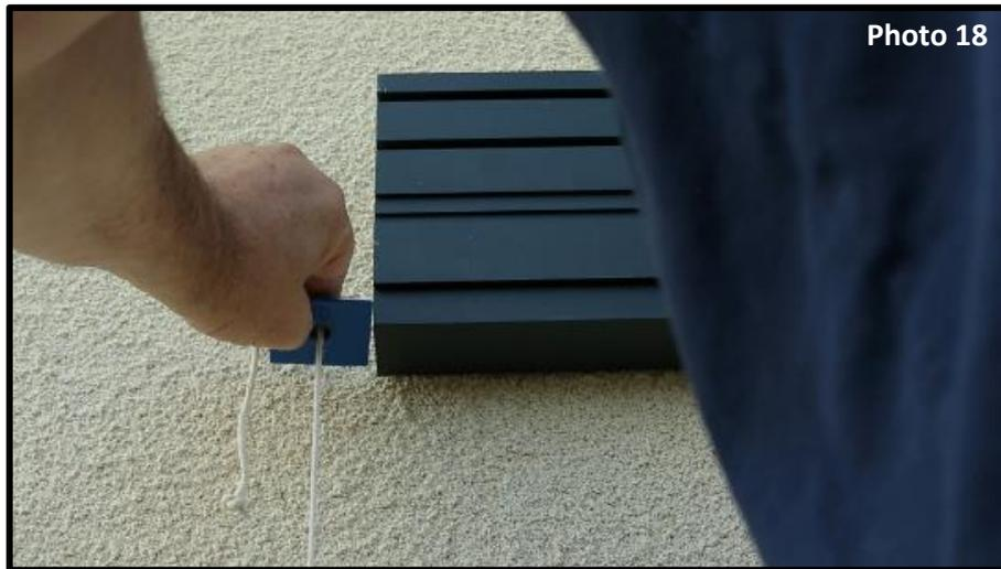
Vous allez maintenant descendre les aplombs des 2 extrémités de votre poutre jusqu'au sol afin de déterminer les points d'équerrage au sol (photo 18).
