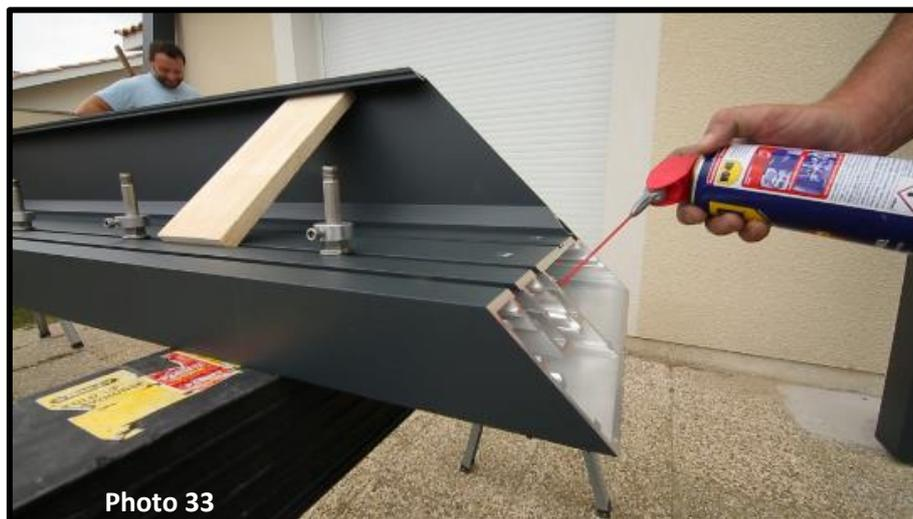
Puis lubrifiez les équerres d'assemblage pour une meilleure pénétration dans les réservations des poutres (photo 33).
