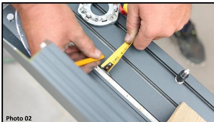
Marquez l'emplacement des trous de fixation à 20 cm de chaque extrémité de la poutre puis tous les 60 cm. Reportez l'emplacement des trous sur la poutre murale pour la percer aux endroits correspondant sur le mur (photo 02).
