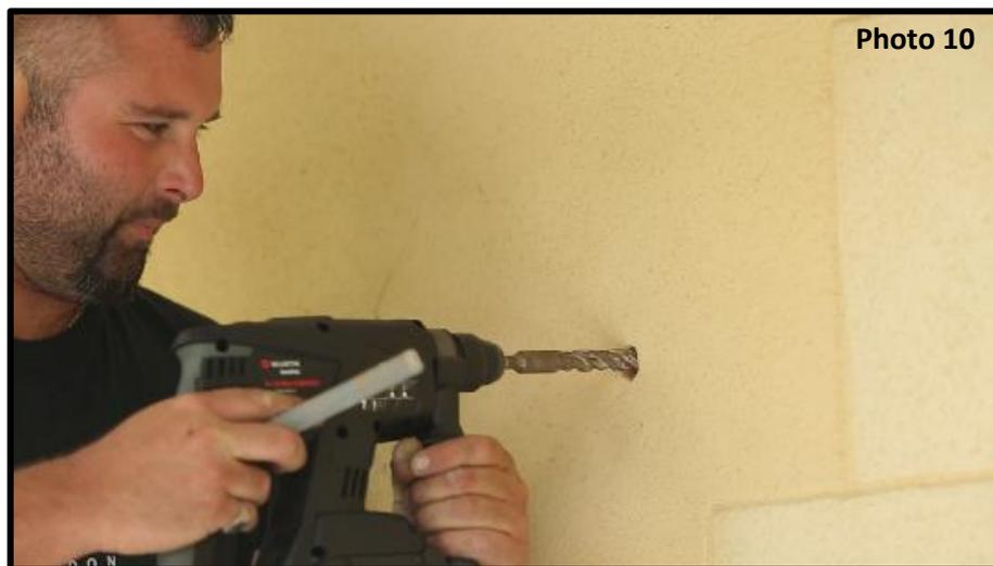
Percez votre mur avec une mèche à béton de 16 mm (photo 10).
