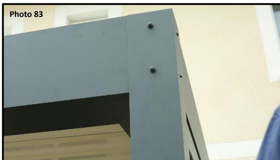
Il ne vous reste plus qu'à installer les bouchons pour masquer les têtes de boulons et la pose de votre pergola est terminée ! (photo 83).
