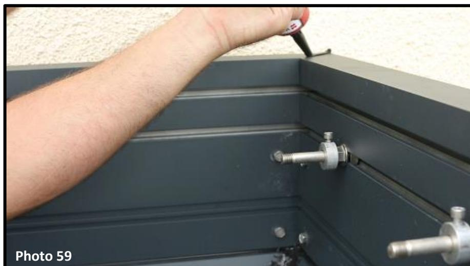
Siliconez le dessus de l'angle des deux poutres, côté intérieur (photo 59).
