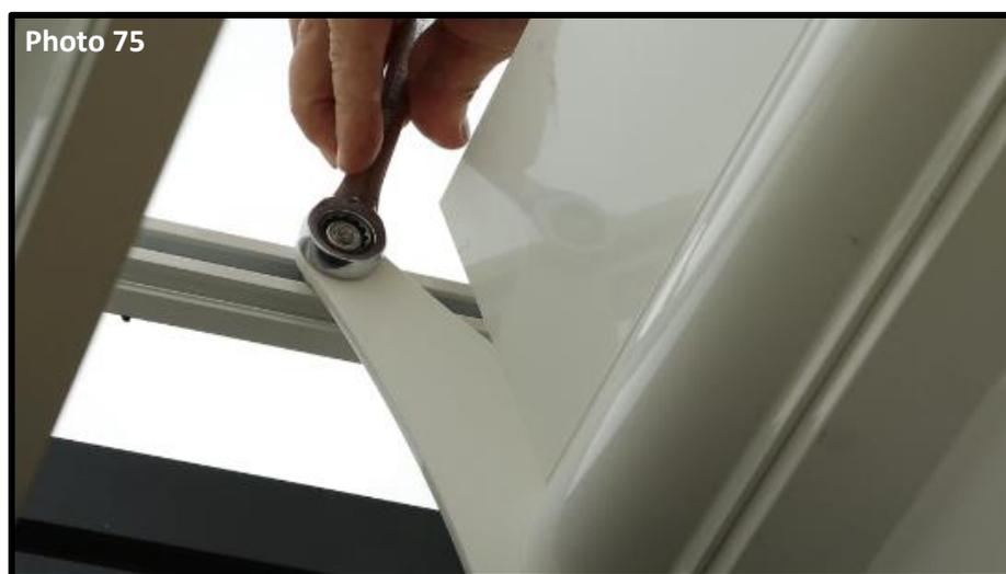
Vissez et serrez à la clé les boulons. Une fois serrés, desserrez-les d'un quart de tour pour donner un peu de jeu et éviter de bloquer la crémaillère contre le support de lames (photo 75).
