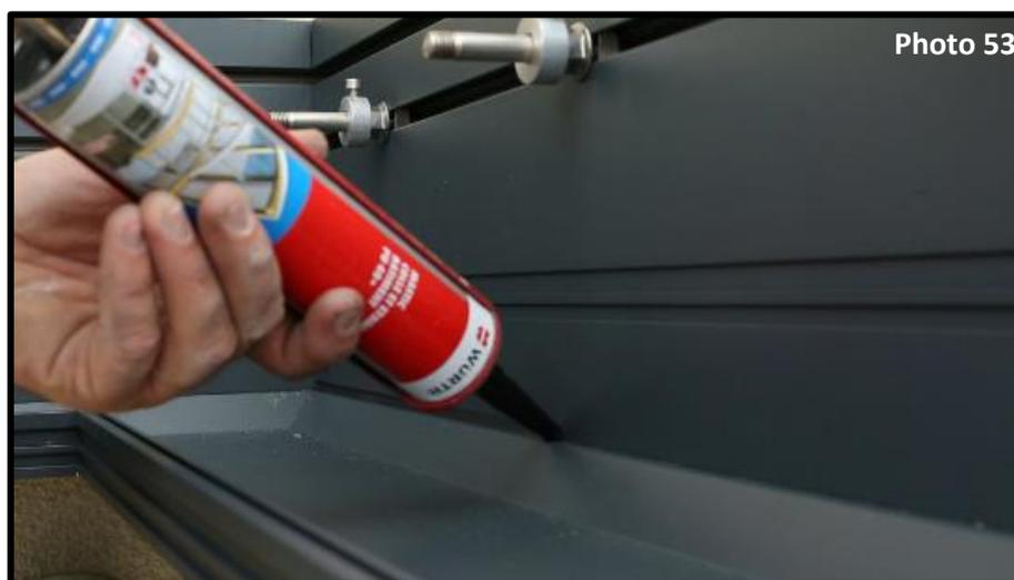
Maintenant siliconez l'angle intérieur d'assemblage (silicone fourni dans le kit de pose) entre le chéneau et la poutre afin d'éviter toute infiltration d'eau (photo 53).
