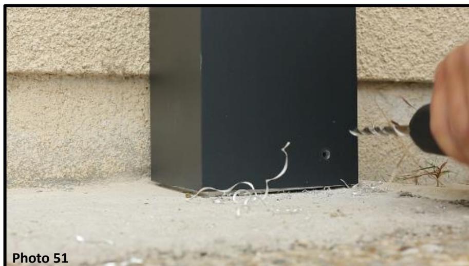
Fixer les poteaux sur les platines : percez l'ensemble avec un foret de 8 mm (photo 51).
