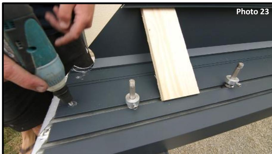
Dévissez les boulons fixés en usine qui maintiennent les équerres d'assemblage pour donner un peu de mou afin de mieux faire coulisser les équerres de fixation (photo 23).
