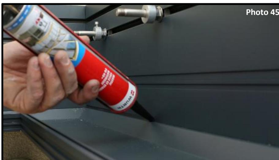
Maintenant siliconez l'angle intérieur d'assemblage (silicone fourni dans le kit de pose) entre le chéneau et la poutre afin d'éviter toute infiltration d'eau (photo 45).
