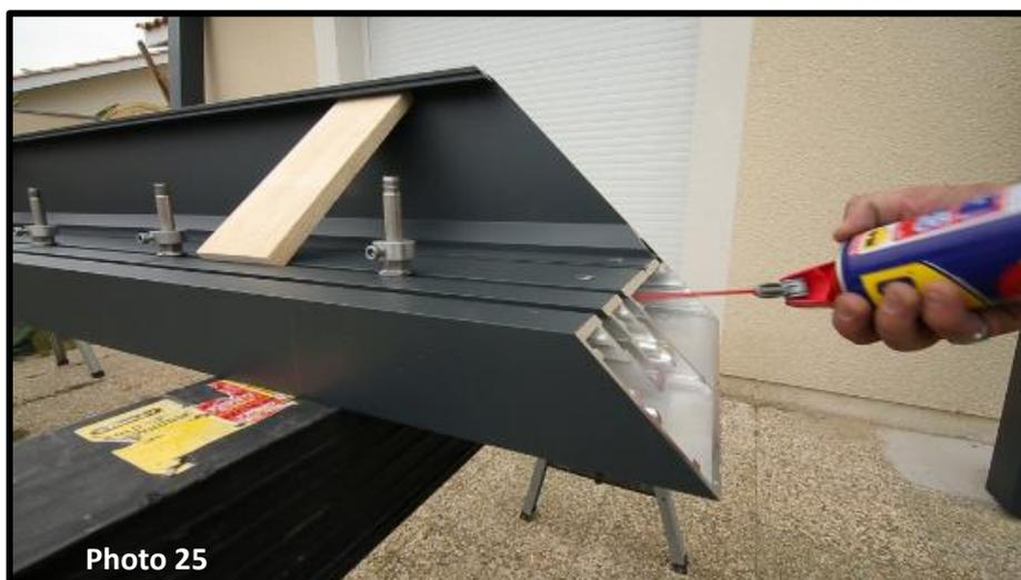
Puis lubrifiez les équerres d'assemblage pour une meilleure pénétration dans les réservations des poutres (photo 25).
