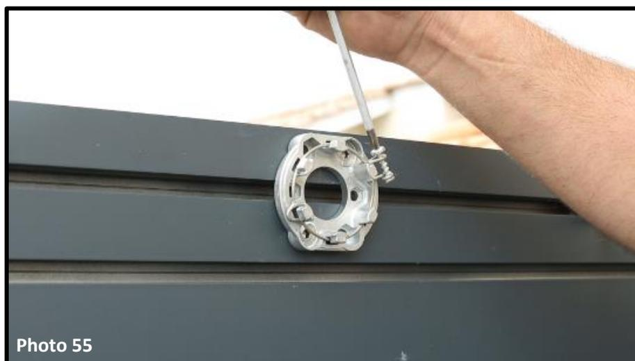
La première lame à installer est la lame moteur. Dévissez le collier de blocage du moteur (photo 56).
