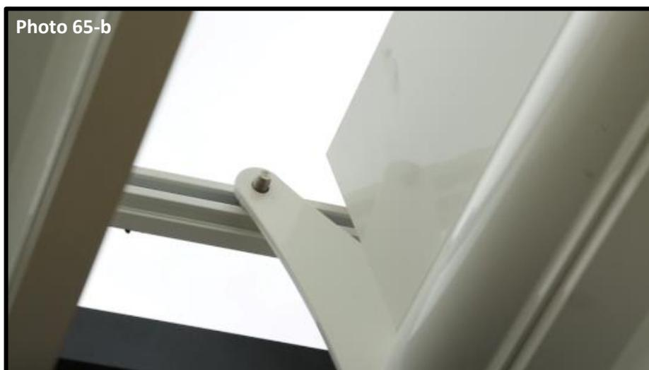
Installez à l'opposé de la lame moteur la dernière lame de la même manière que la lame moteur et fixez la crémaillère sur les deux lames (photo 65-b).
