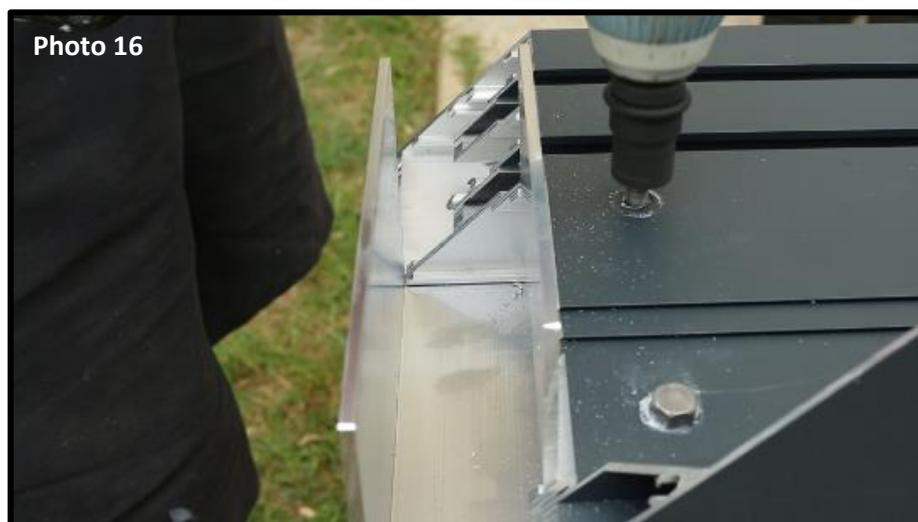
Dévissez les boulons fixés en usine qui maintiennent les équerres d'assemblage pour donner un peu de mou afin de mieux faire coulisser les équerres de fixation (photo 16).
