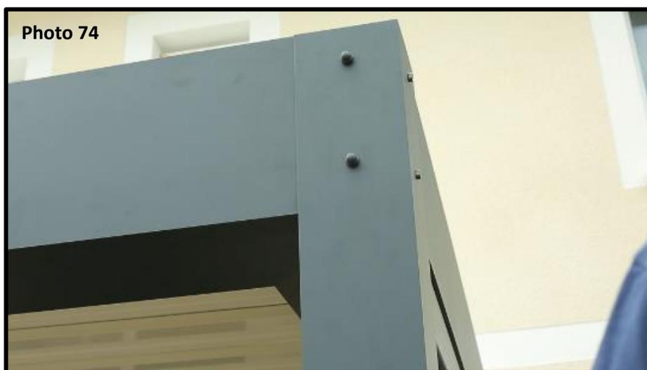
Il ne vous reste plus qu'à installer les bouchons pour masquer les têtes de boulons et la pose de votre pergola est terminée ! (photo 74).
