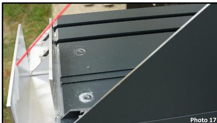
Puis lubrifiez les équerres d'assemblage pour une meilleure pénétration dans les réservations des poutres (photo 17).
