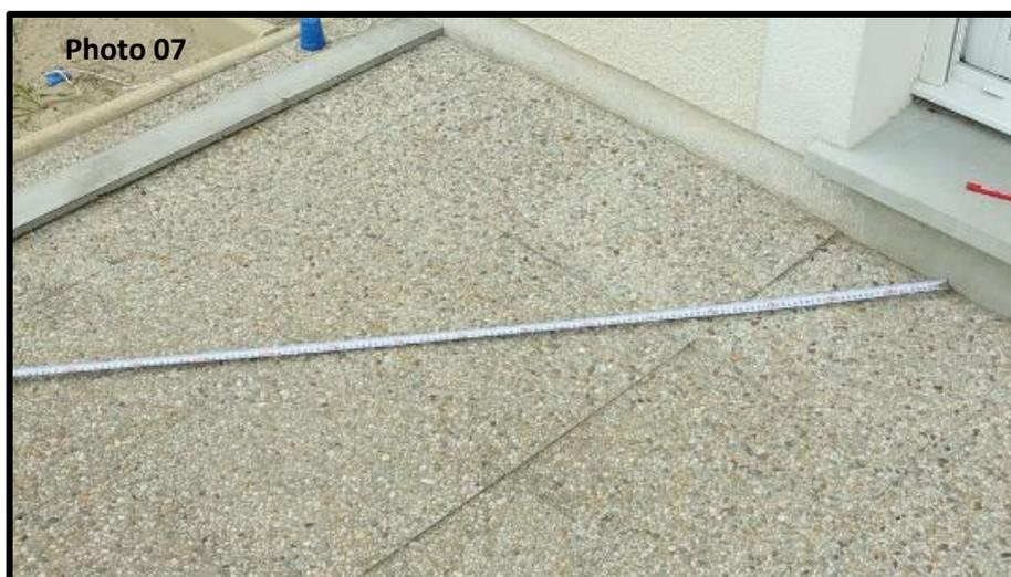
A l'aide d'un mètre ruban métallique, rejoignez les 2 traits tracés, celui parallèle à la façade à 1,20 mètre et celui perpendiculaire à 1,60 mètre en vous assurant que la règle soit restée bien droite et d'aplomb à votre mur (photo 07).
