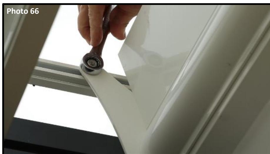
Vissez et serrez à la clé les boulons. Une fois serrés, desserrez-les d'un quart de tour pour donner un peu de jeu et éviter de bloquer la crémaillère contre le support de lames (photo 66).
