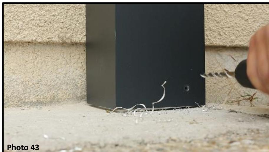
Fixer les poteaux sur les platines : percez l'ensemble avec un foret de 8 mm (photo 43).
