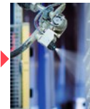
Application du traitement et de la protection
