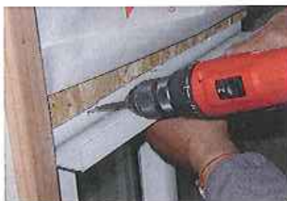
Fixation de l'habillage horizontal
