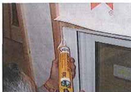
Cordon d'étanchéité sur montant vertical
