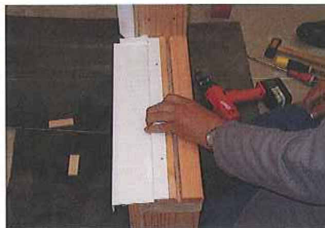
Positionnement de la bavette
