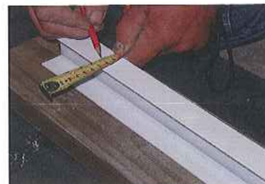
Traçage pour perçage des profilés d'habillage extérieurs (à 50 mm de chaque extrémité, entraxes d'environ 500 mm)
