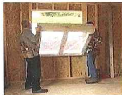
Présentation de la menuiserie équipée de ses pattes de fixation
