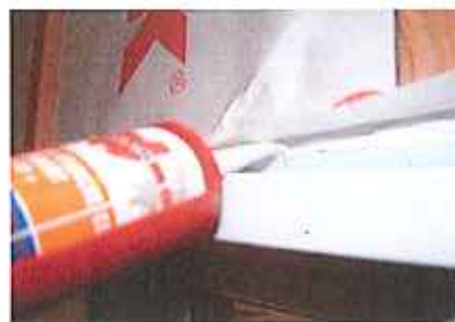
Cordon d'étanchéité sur traverse haute
