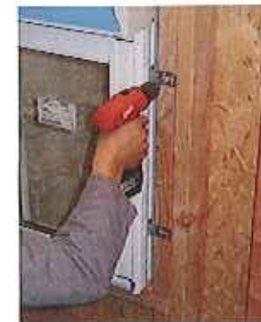
Fixation du bloc menuiserie
