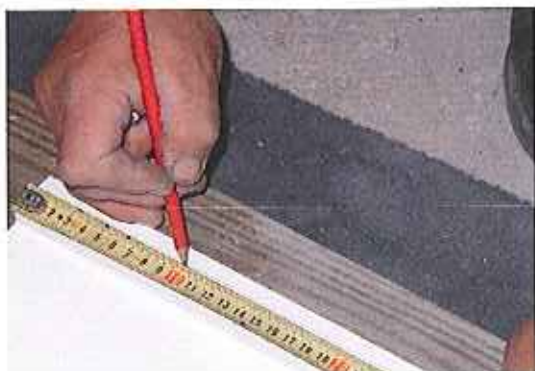
Traçage pour perçage de la bavette (à 100 mm de chaque extrémité, puis entraxes d'environ 600 mm)
