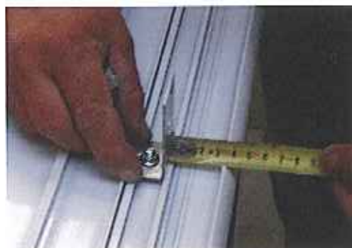
Réglage de l'équerre par rapport au recouvrement (voir schéma ci-contre)
