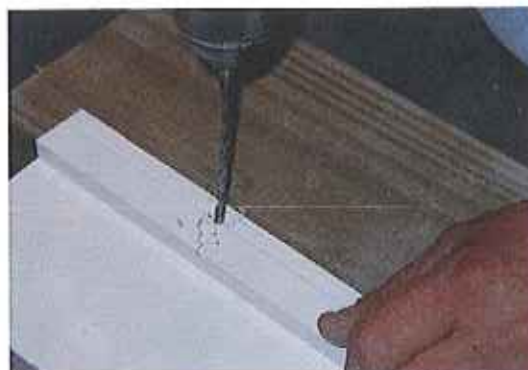
Percage de la bavette (diamètre 4,5 mm)
